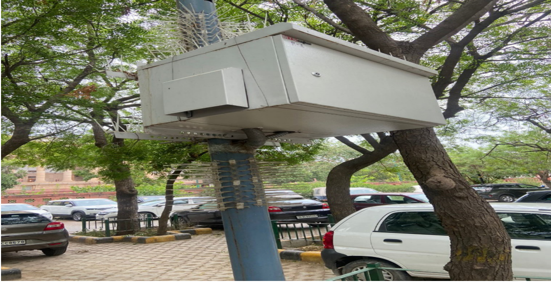
किसी भी प्रकार के मौसम के लिए कैमरों को बिजली आपूर्ति के लिए इंसुलेटेड रैक – गृह मंत्रालय का सीसीटीवी सिस्टम
